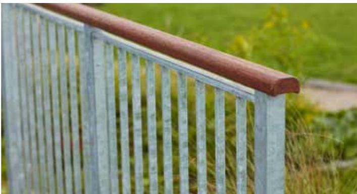
Stahlpfosten mit Handlauf in Mahagoni behandelt mit wasserbasiertem Öl
